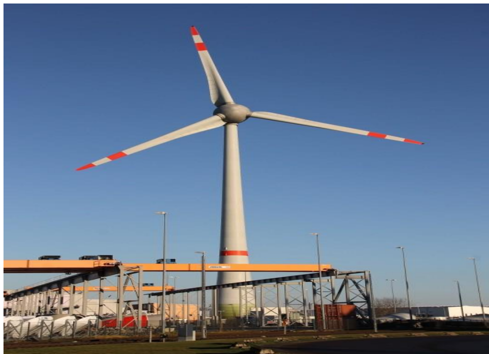
7 – сурет - Enercon E - 126 (P = 7 МВт) үш қалақты жел генераторы
